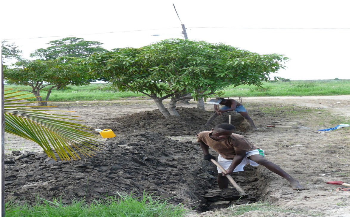
Inizio lavori per il muro di cinta
